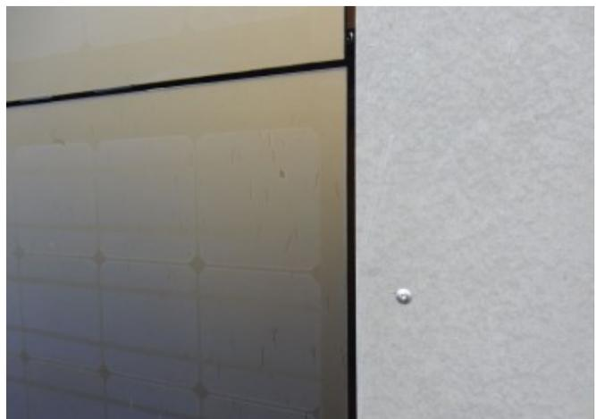
Detail eines goldfarbenen BIPV-Moduls © Baubüro in situ AG
