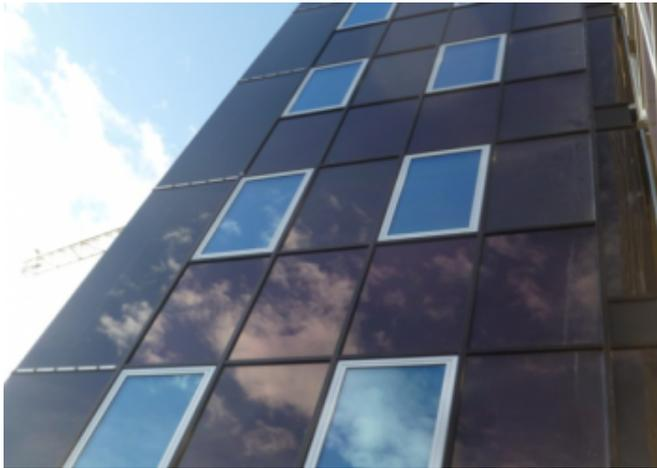
Das BIPV-System des Enzian Office: Die Module ersetzen die opaken Fassadenabschnitte (unter den Fensterzeilen) und die halbdtransparenten Bereiche (neben den Fenstern) © Eurac Research
