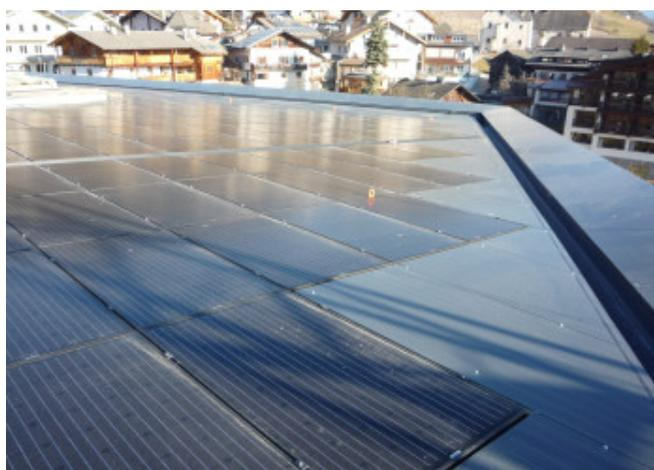
Dei moduli finti sono stati installati per la finitura della copertura BIPV © Arch. Albert Colz
