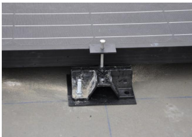
Struttura di fissaggio del sistema BIPV: sono visibili le speciali staffe laterali, ancorate al tetto in cemento dell'edificio © Elektrostudio
